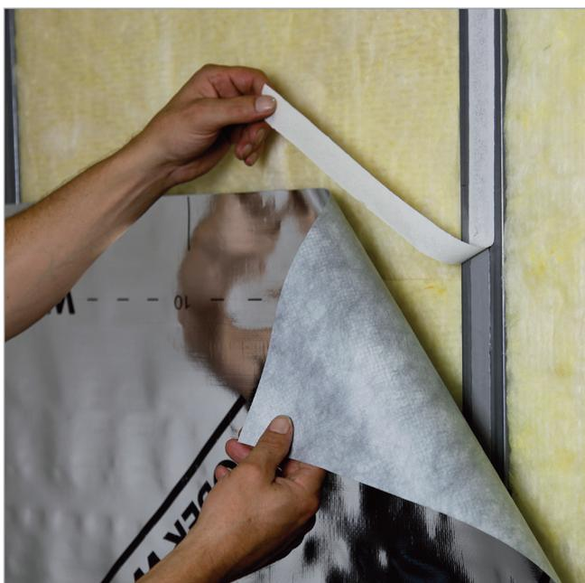
Butylon® склеивает и герметизирует пленки, укладываемые без провисания, а также паронепроницаемые пленки во внутренней и внешней зонах.
