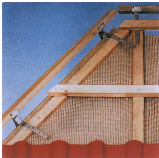
Рис. 7 КРЕПЛЕНИЕ КОНЬКОВОЙ ОБРЕШЕТИНЫ (СМ. РИС. 48, 52, ПРИЛОЖЕНИЕ Г)
